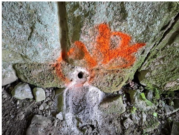
Obtížné vrtání do maximální délky vrtáku 1,5 m.
